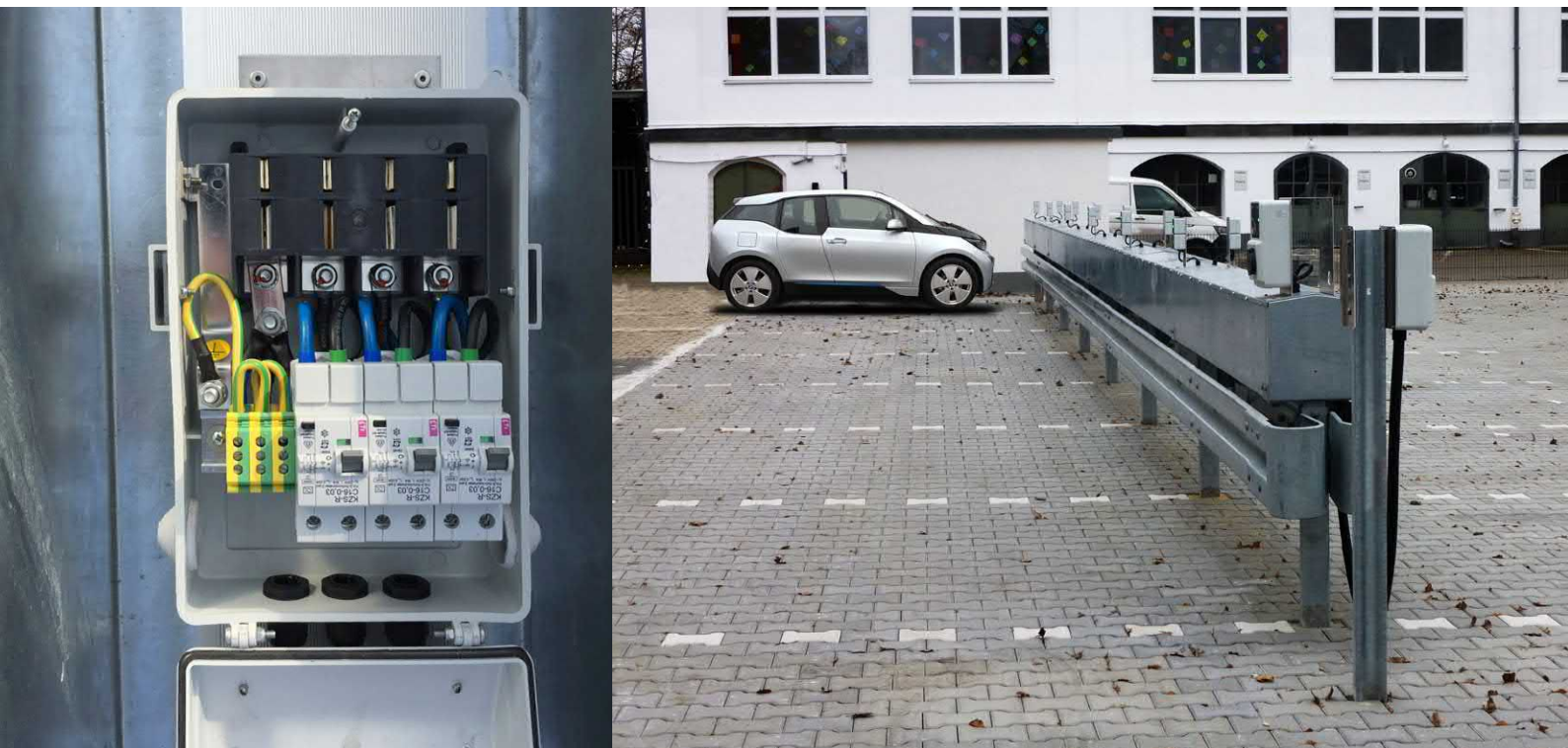
das in Berlin erprobte HP Busbars System GGD Verteil-System für Stromlasten bis 1000 A
